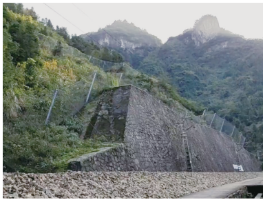
图 3 路基开挖形成的边坡
