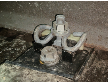
图 20 新型客货共线铁路扣件上道试铺
