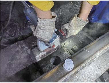
图 19 支承块挡肩打磨
