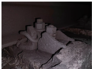
图 1 扣件离缝
