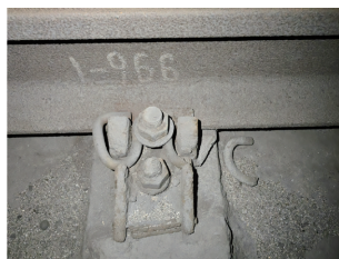
图 4 弹条折断
