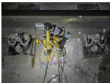
图22 新型客货共线铁路扣件动力性能检测
