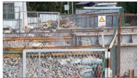
图 13 龙石路南延线项目施工现场钢轨自动降温
